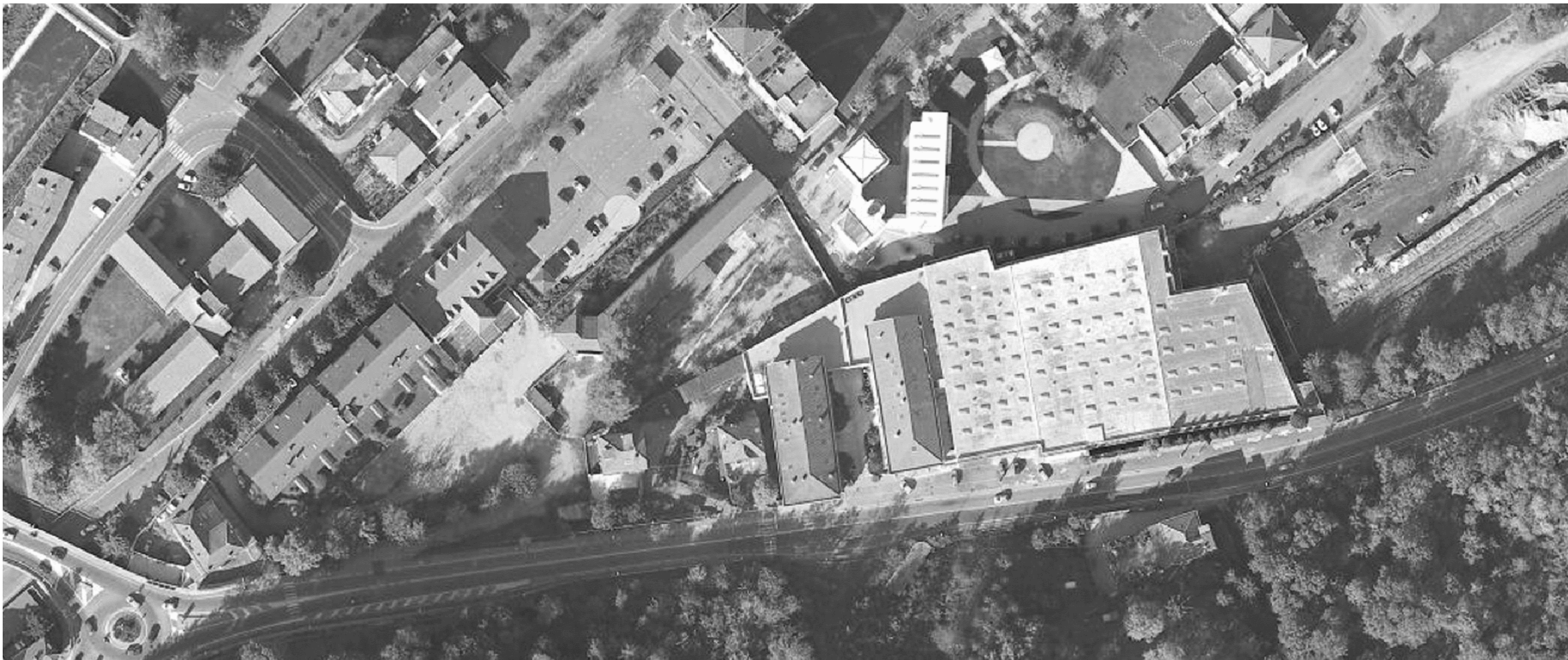
FOTO AEREA STATO ATTUALE
