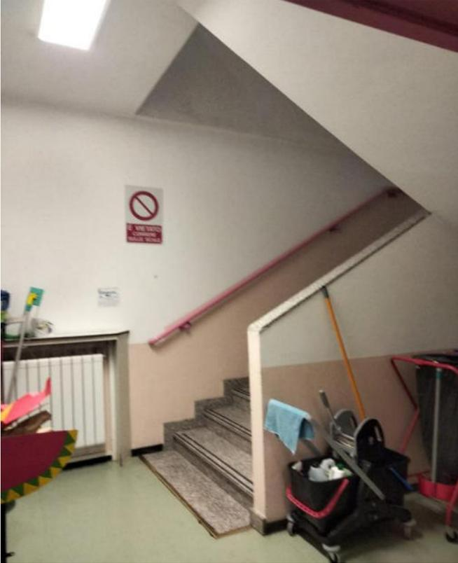
Vista la larghezza della scala è possibile installare un montascale con seggiolino, montandolo dal lato interno della scala (muretto divisorio delle due rampe) e realizzando un binario che possa terminare nella attuale postazione dei carrelli delle pulizie (ripostiglio aperto).
