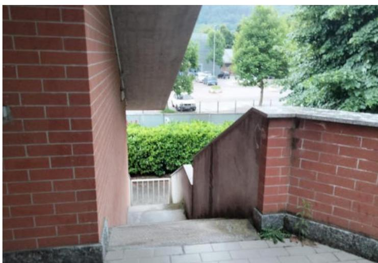
Via di esodo senza aiuto per disabili e scala stretta, quindi non è possibile installare un seggiolino e sfruttarla come via di esodo. Si potrebbe inserire un elevatore pneumatico sul lato sinistro della facciata
