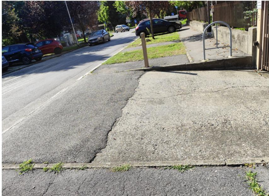
Rampa in pendenza e cancello di uscita garage direttamente su strada senza arretramento non consente il posizionamento di strisce pedonali ed il percorso disabili davanti a questa disattenzione progettuale obbliga ad un giro della carrozzina senza strisce ed in prossimità della carreggiata veicolare
