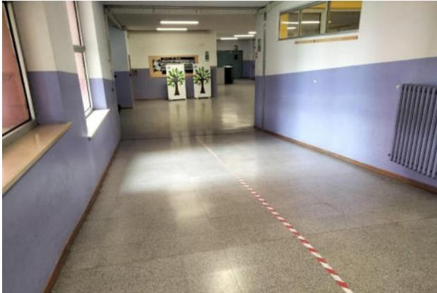
Nel corridoio in pendenza si consiglia un corrimano nel centro del corridoio, oppure lato muro spostando il termosifone.
